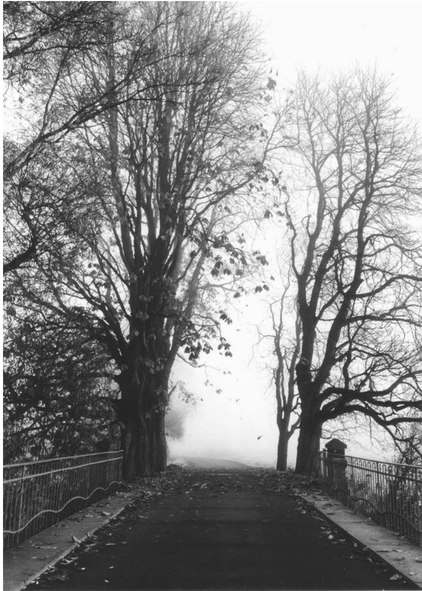
Die Dutenhofener Lahnbrücke wurde 1895/96 als Zufahrt zum Weideland auf der nördlichen Lahnseite erbaut.
